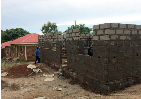
Neubau der Küche
