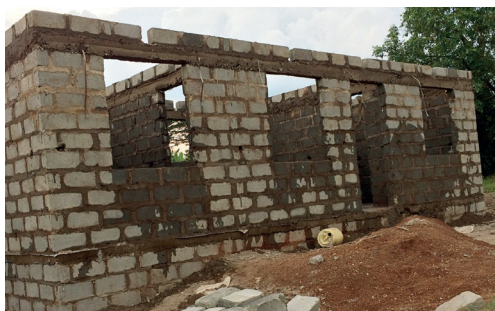
Der Rohbau steht schon
